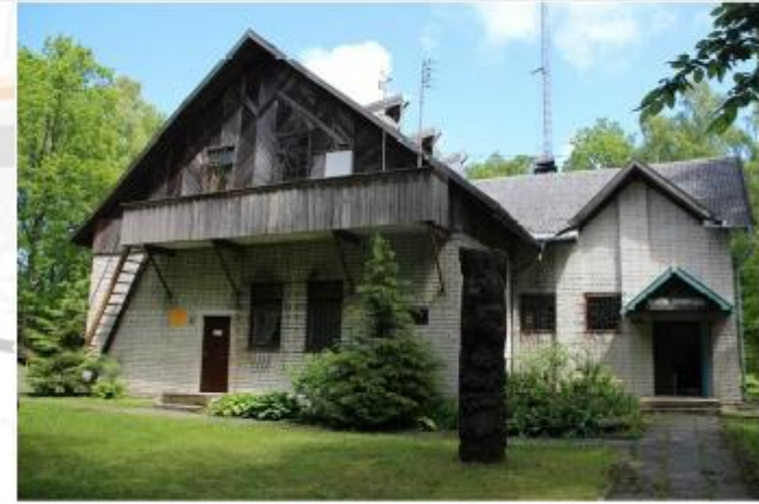
1 ОСУЩЕСТВЛЕНИЕ РЕКОНСТРУКЦИИ ЗДАНИЯ МУЗЕЯ ЛЕСА
