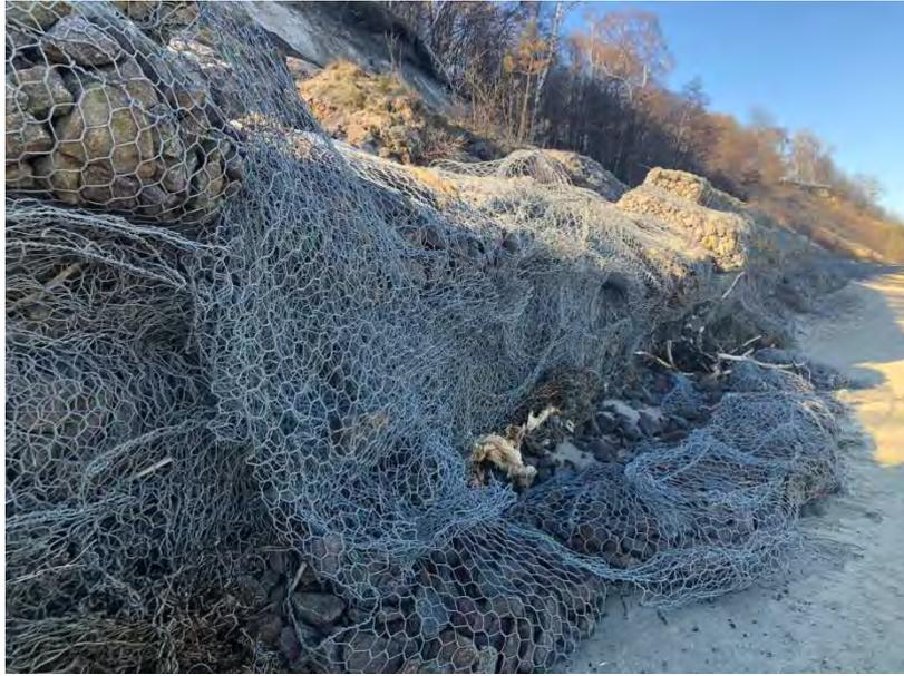
Рисунок 1.16 – Участок 4 – Частично разрушенные габионы со следами волнового заплеска
