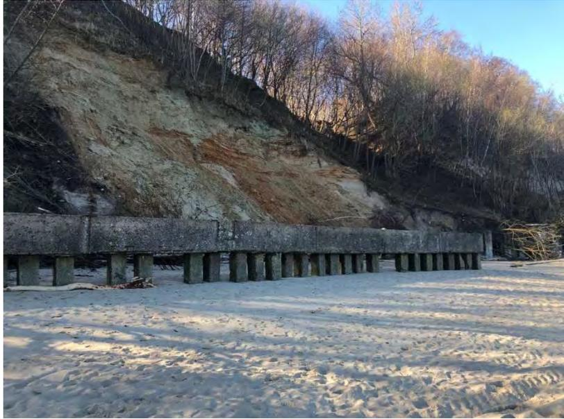
Рисунок 1.10 – Участок 3 – Активный береговой уступ на участке разрушения
