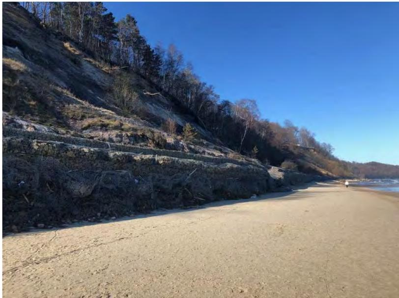
Рисунок 1.15– Участок 4 – Частично разрушенные габионы
