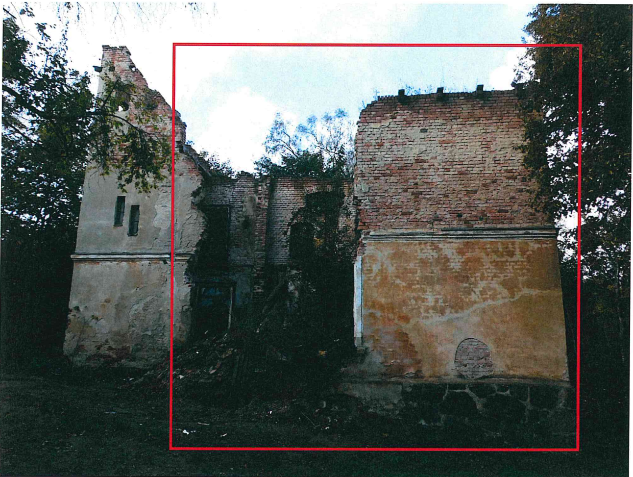
Основной объём. Восточный фасад.
