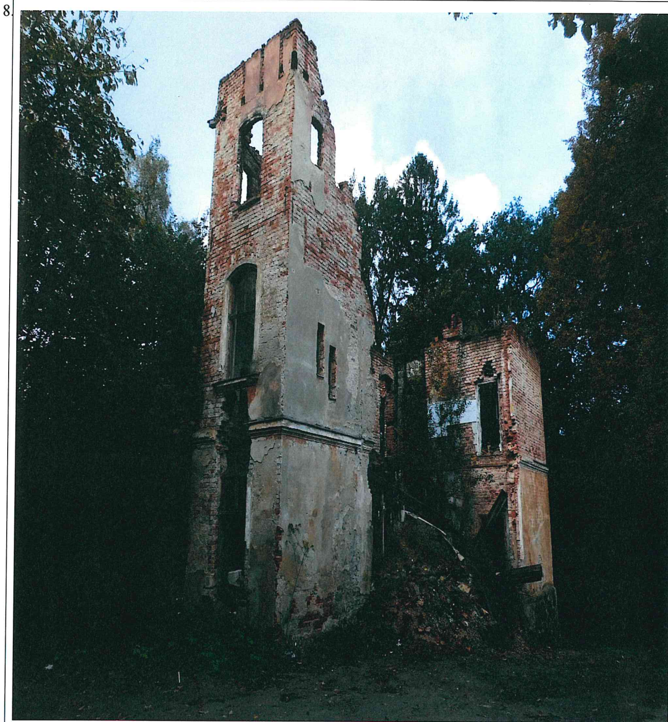
Башня. Восточный фасад.
