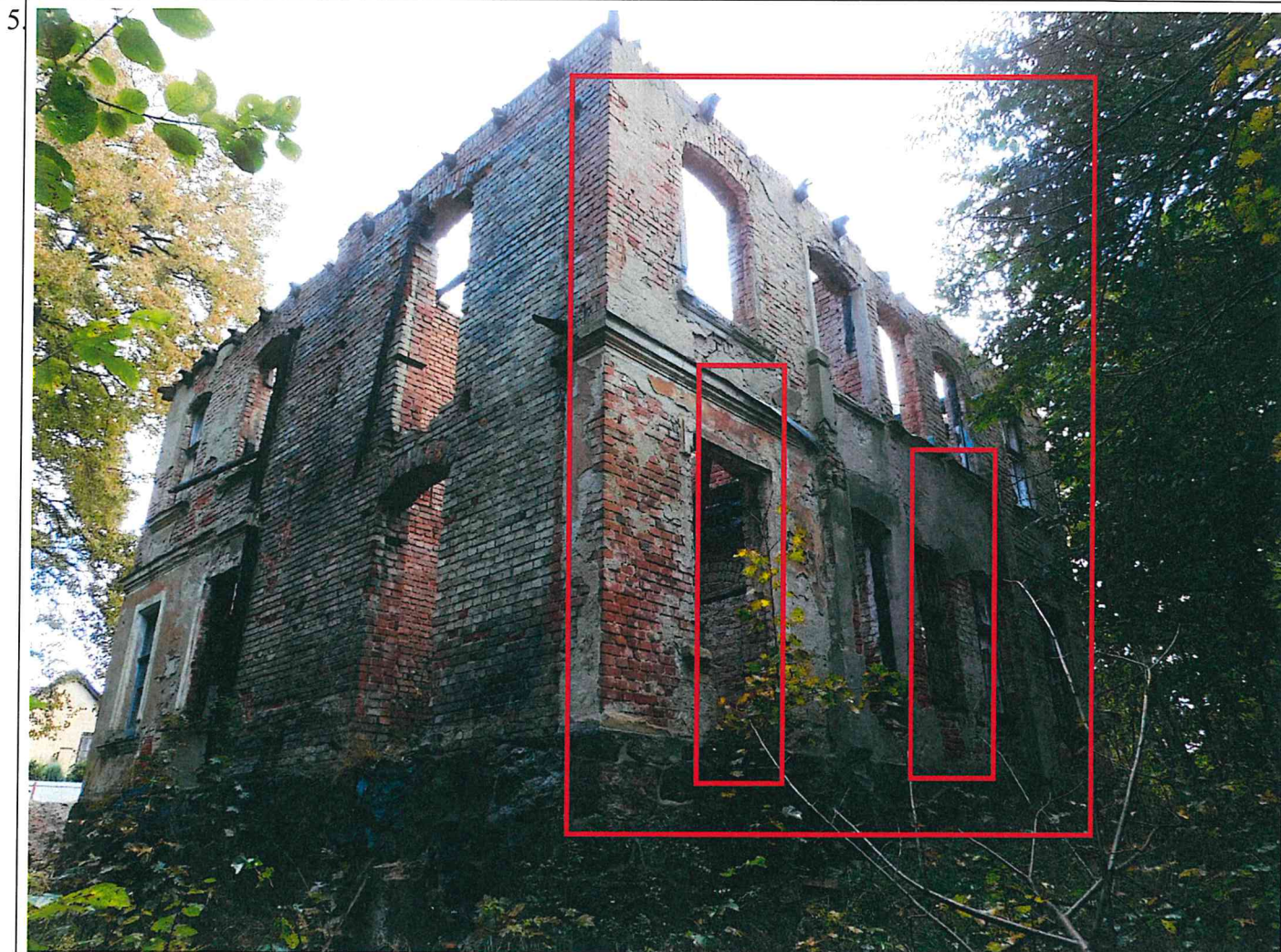
Основной объём. Западный фасад.
