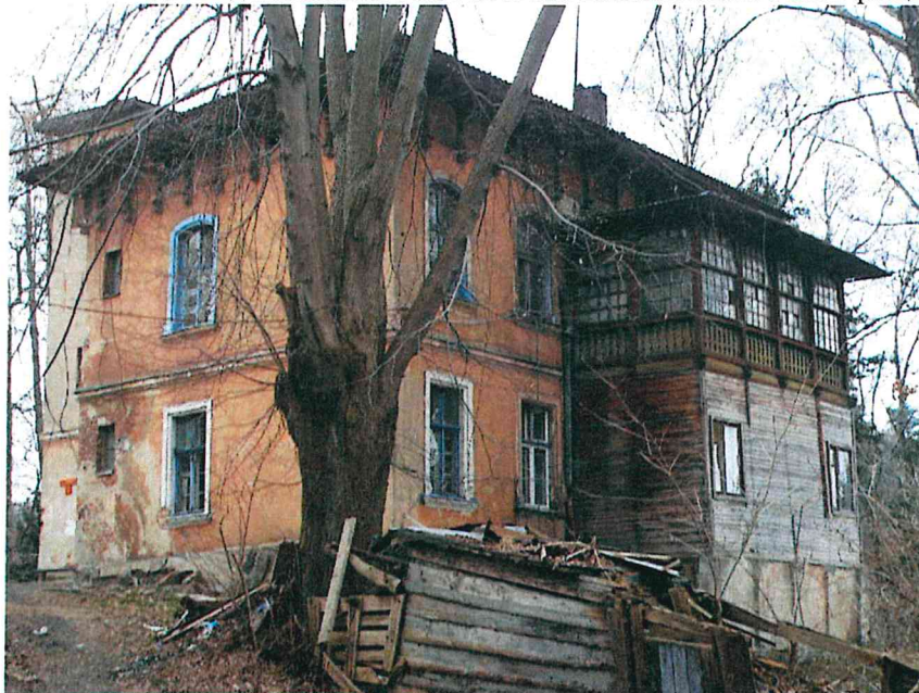
Фото 2006 года. Вид Памятника с северо-востока. Северный и восточный фасады.
