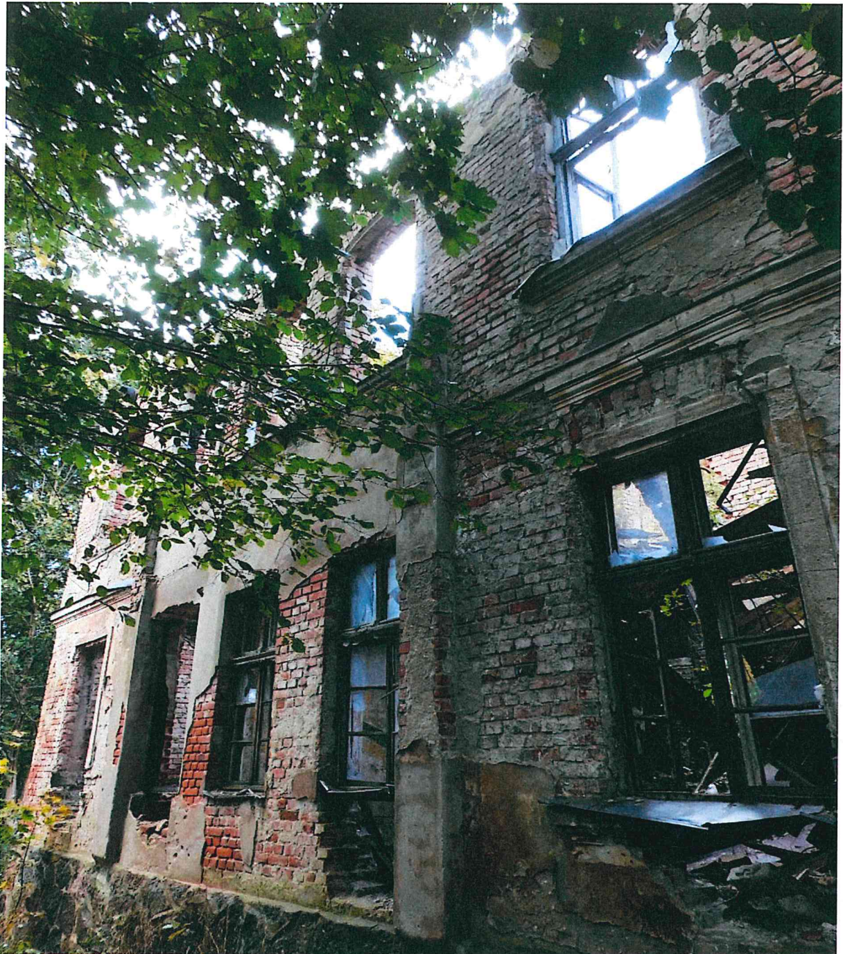
Основной объём. Западный фасад.
