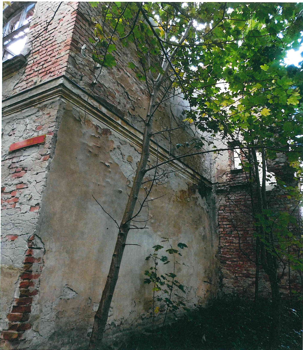
Основной объём. Южный фасад.
