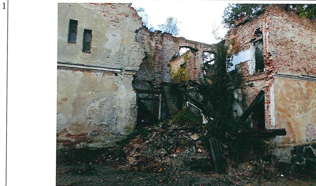
Восточный фасад. Основной объем.
